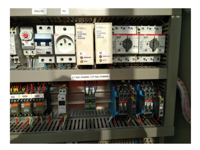
Le contact sec de la pompe 1 a été utilisé pour asservir le préleveur automatique au fonctionnement de cette pompe, en service lors de la mesure.
